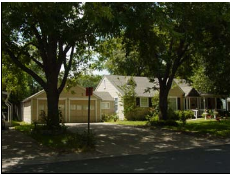
1500 N. Ferris Ave., erected c. 1946
