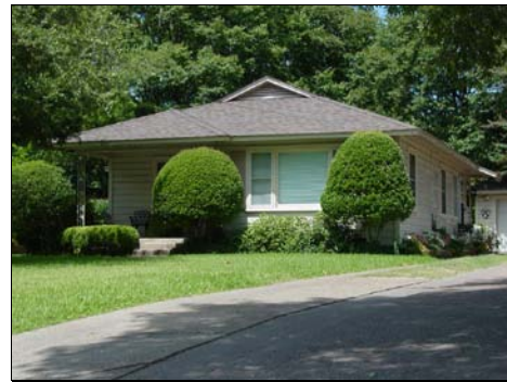
1415 N. Ferris Ave., erected c. 1946
